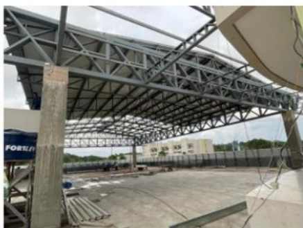
Imagens 07 e 08: Confeção e montagem de estrutura metálica da cobertura.
