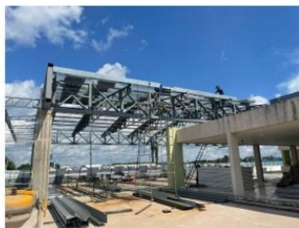
Imagens 07 e 08: Confeção e montagem de estrutura metálica da cobertura.
