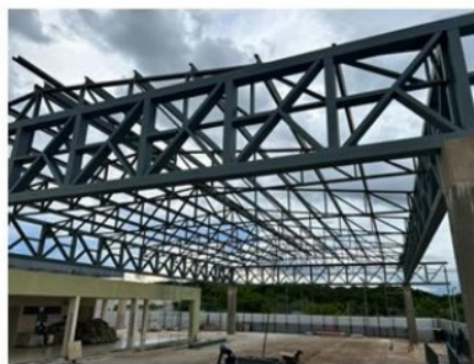
Imagens 05 e 06: Confeção e montagem de estrutura metálica da cobertura.
