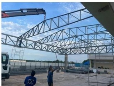
Imagens 05 e 06: Confeção e montagem de estrutura metálica da cobertura.
